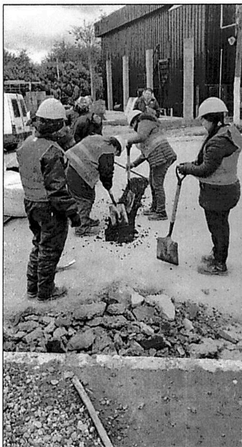
Fotografía – Programa Imagen Colectiva – Capacitación sobre colocación de mezcla asfáltica en frío.
