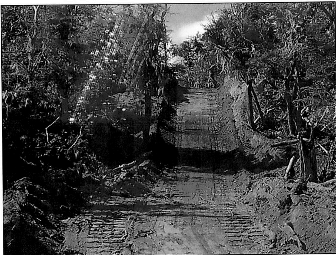
Fotografía –Corta fuego ejecutado por Constructora Dos Arroyos SA – incendio Tolhuin 2022
