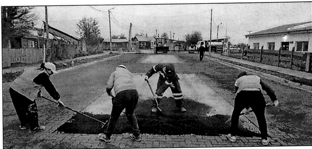
Fotografía – Ejecución de veredas con Biomezcla asfáltica en obra de Constructora Dos Arroyos, realizada por mujeres del programa Imagen Colectiva, contratadas especialmente para llevar a cabo la tarea luego de su capacitación.
