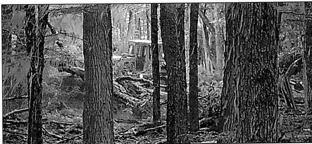
Fotografía – Topador de Constructora Dos Arroyos ejecutando corta fuego – incendio Tolhuin 2022
